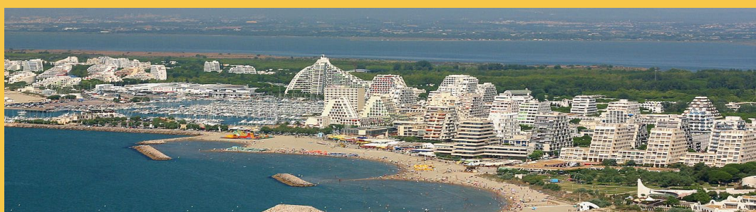
Photo : La Grande-Motte, Wikipédia, 2013.
